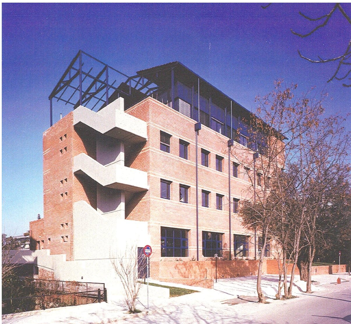
Όψη κτηρίου γραφείων Τεχνικής Εταιρείας Βόλου
